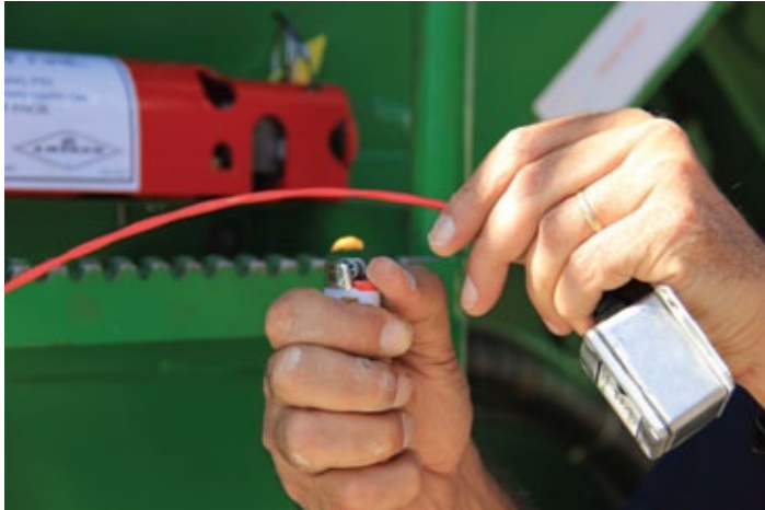
Aquecimento do cabo sensor linear de temperatura (simulação de um princípio de incêndio)
